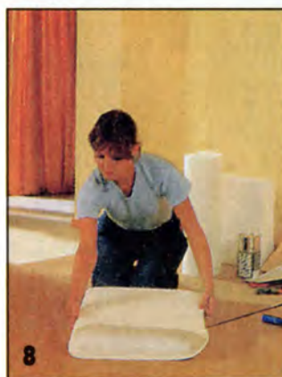
8 Стиропоровые блоки можно обклеить и стеклотканевыми обоями.
