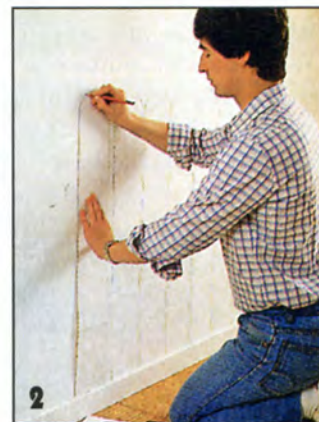
«Забор из фигурного штакетника» размечают на стене по шаблону.
