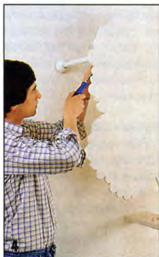
Установив предварительно окрашенную в белый цвет стойку вешалки в виде дерева, монтируют штангу для плечиков.
