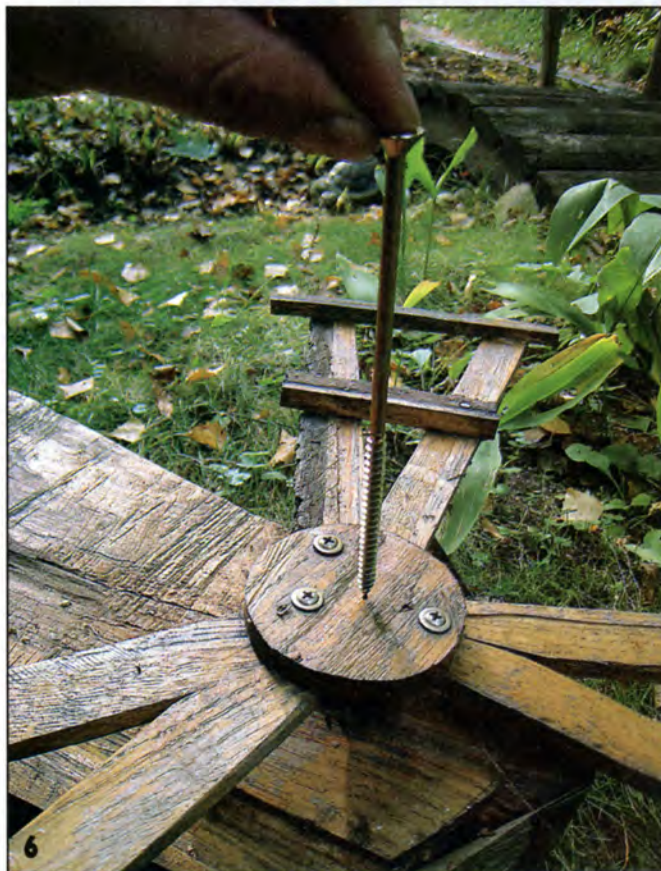
6 Длинный саморез служит осью, на которой вращается конструкция.
