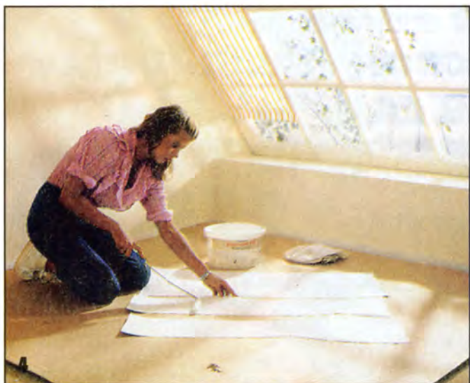
На текстильные обои, раскроенные ножницами по направляющей планке, валиком наносят дисперсионный клей.
