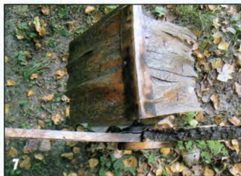
7 Кровлю из дубового шпона украшает медный конёк.
